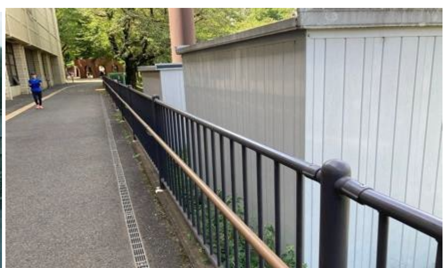
既存のフェンス
