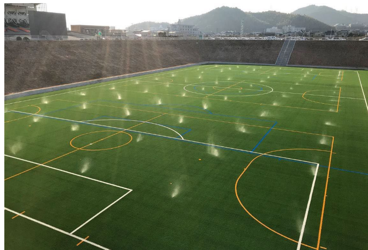
■散水システム稼働状況
